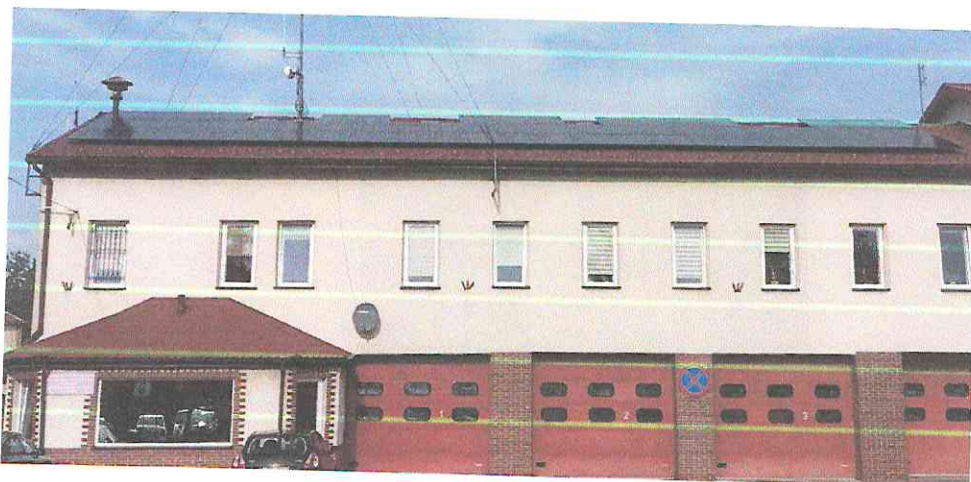
Instalacje odnawialnych źródeł energii
